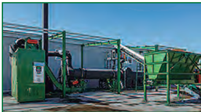
El pasado 24 de mayo comenzó la instalación de la maquinaria para secado y limpieza de hueso de aceituna de Secaderos La Loma en Aceites Guadalentín (Pozo Alcón, Jaén).
